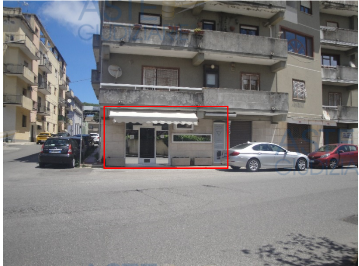
Vista del locale da Via Palach –
