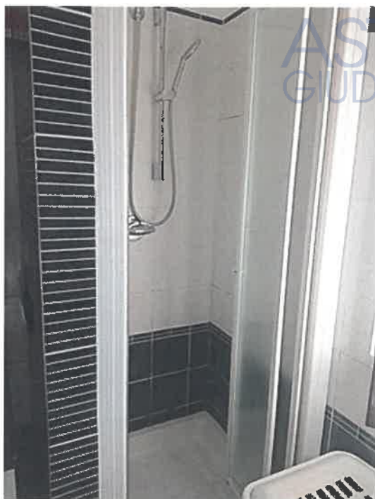
foto n. 13 - particolare box doccia
