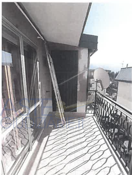
foto n. 19 - vista balcone - fronte sud
