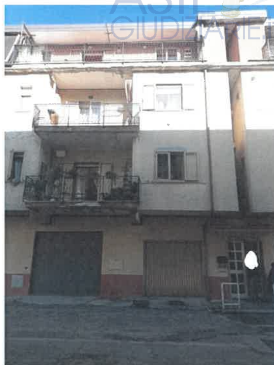
foto n. 2 -prospetto ingresso Località La Prisa - fronte sud
