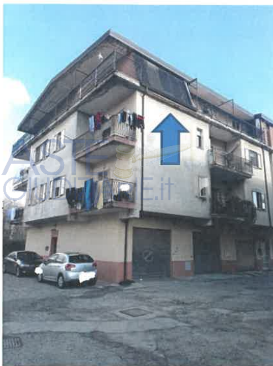
foto n. 1 - prospetto Località La Prisa – fronte sud-ovest
