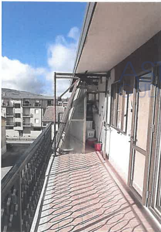
foto n. 17 - vista balcone - fronte sud
