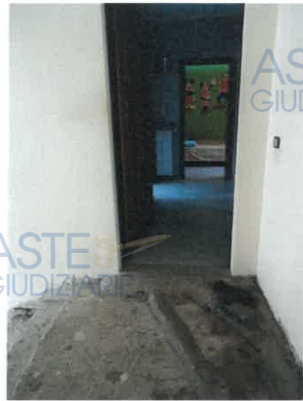
Ingresso al sub 1105
