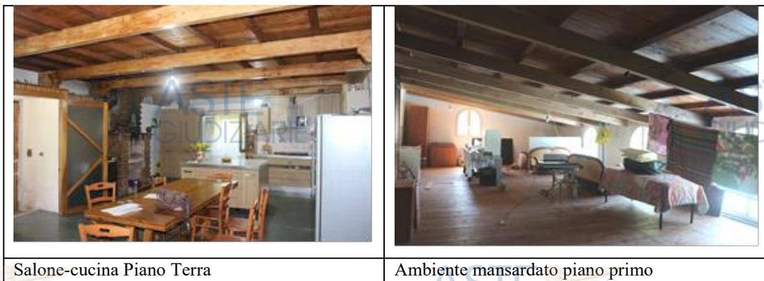
La struttura portante è in muratura, il solaio intermedio e il tetto di copertura sono con struttura portante in legno. Il collegamento tra i piani avviene tramite una scala in legno. Le rifiniture sono di tipo civile. Gli infissi si presentano di diverse tipologie:
