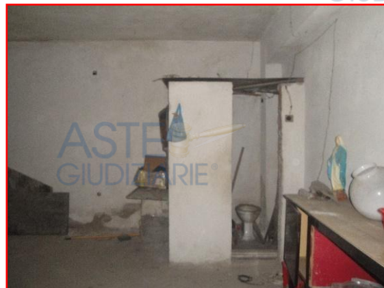
Vista del wc
