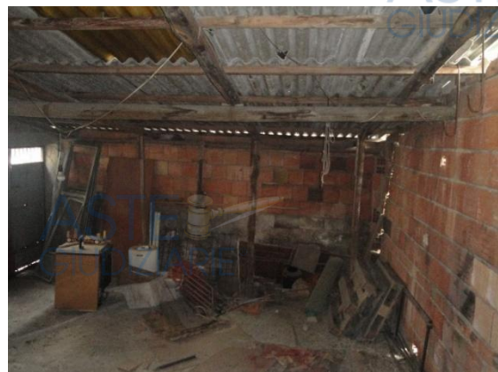
Vista interna del subalterno n. 1
