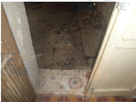
Vista dell'accesso al sub 1 dal sub n.2
