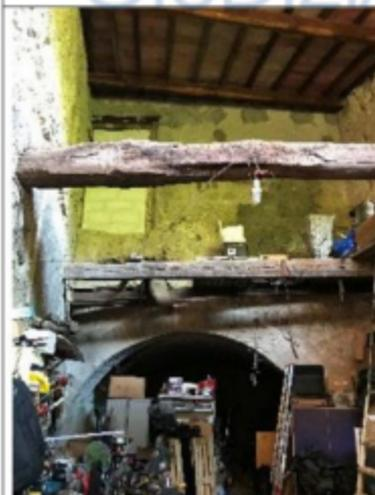
Vista interno locale p.la 36 sub 3, dove si evidenziano le travi dove in precedenza era posato il solaio del secondo vano della p.la 36 sub 2 e la porta murata
