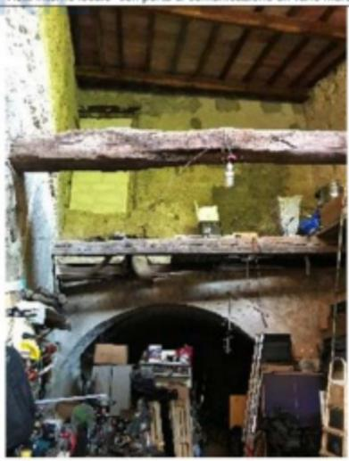
Vista interno locale p.la 36 sub 3, dove si evidenziano le travi dove in precedenza era posato il soffitto di legno, ora demolito. p.la 36 sub 2 e la porta murata
