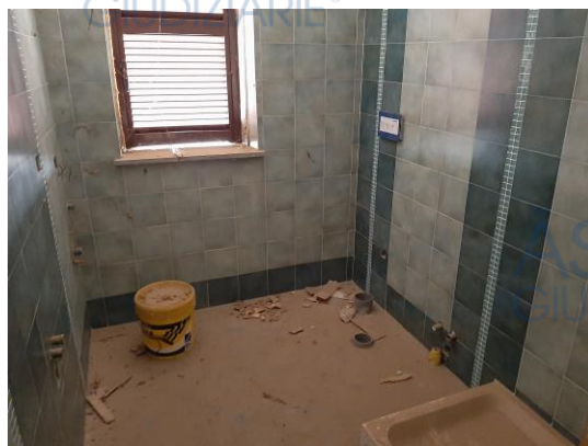
Immagine 10 – Vista bagno piano terra
