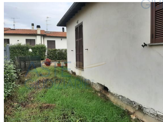
Immagine 8 – Vista esterno fabbricato
