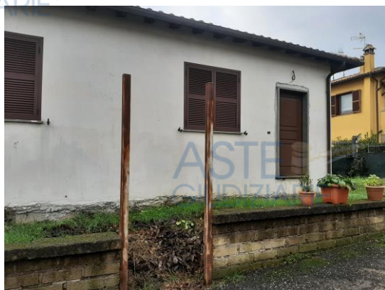
Immagine 1 – Vista esterna piano terra
