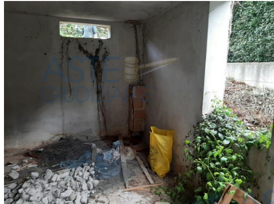
Immagine 6 – Vista piano seminterrato
