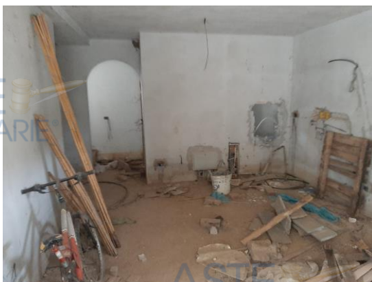
Immagine 5 – Vista piano seminterrato
