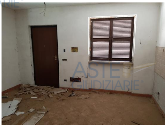
Immagine 9 – Vista piano terra
