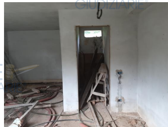
Immagine 7 – Vista piano seminterrato
