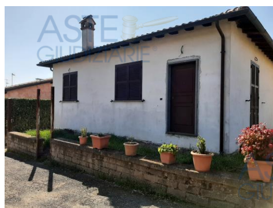
Immagine 12 – Vista esterna del fabbricato lato strada
