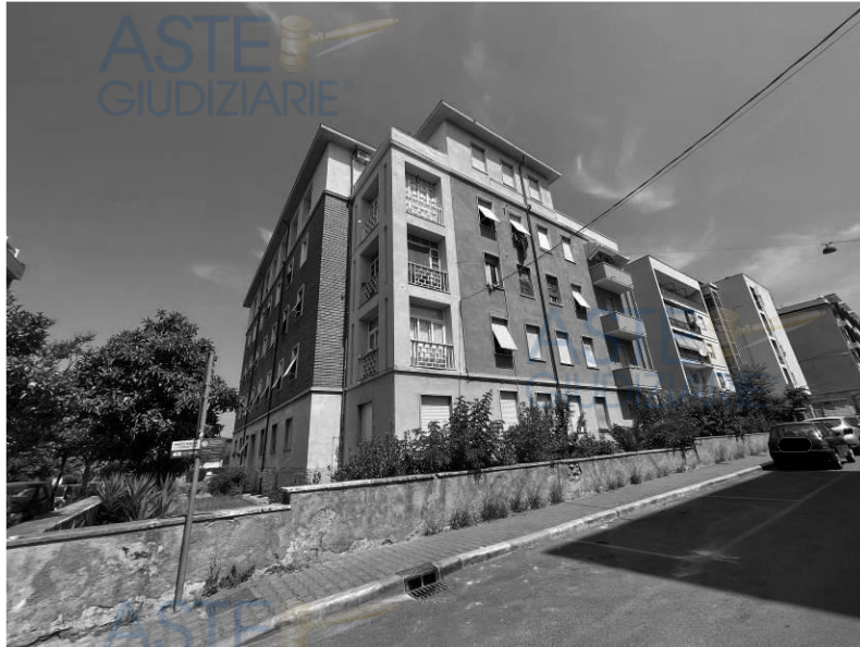
Foto 1 – vista generale dell'edificio da via Turati
