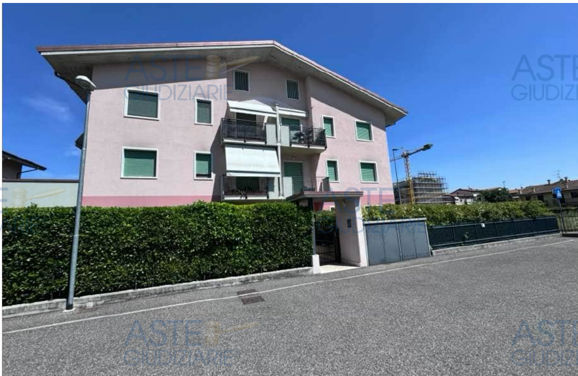
FOTO 1 - Fronte ovest via Buzzati
