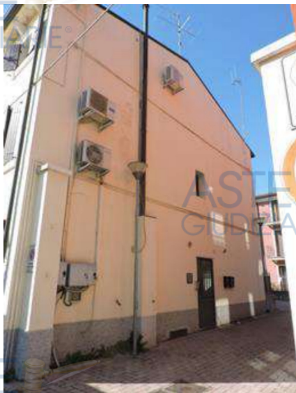
Foto 3 Fronte nord e portone di accesso area antistante
