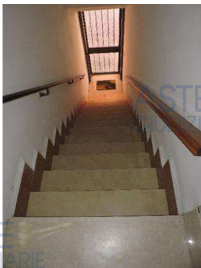
Foto 5 vano scale comune
