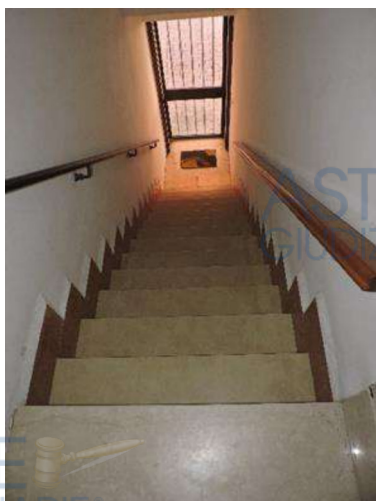
Foto 5 vano scale comune
