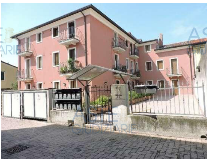
Foto 2 Ingresso pedonale e Fronte est fabbricato
