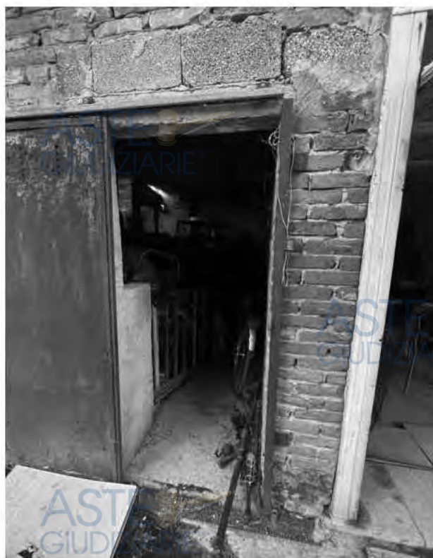
FOTO 16 - Ripostiglio piano terra 2.b
