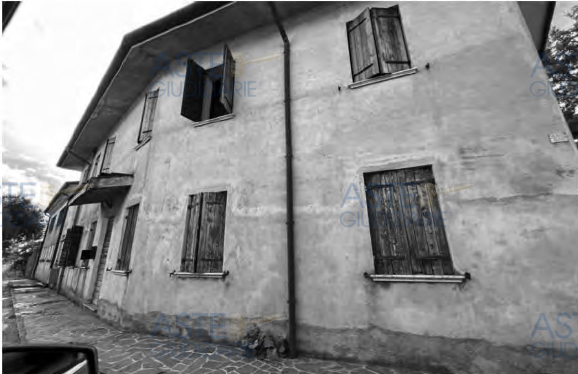
FOTO 1 - Fronte nord 3.d
