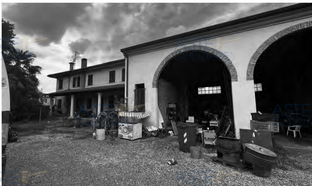
FOTO 10 - Fronte sud 3.d e 3.c
