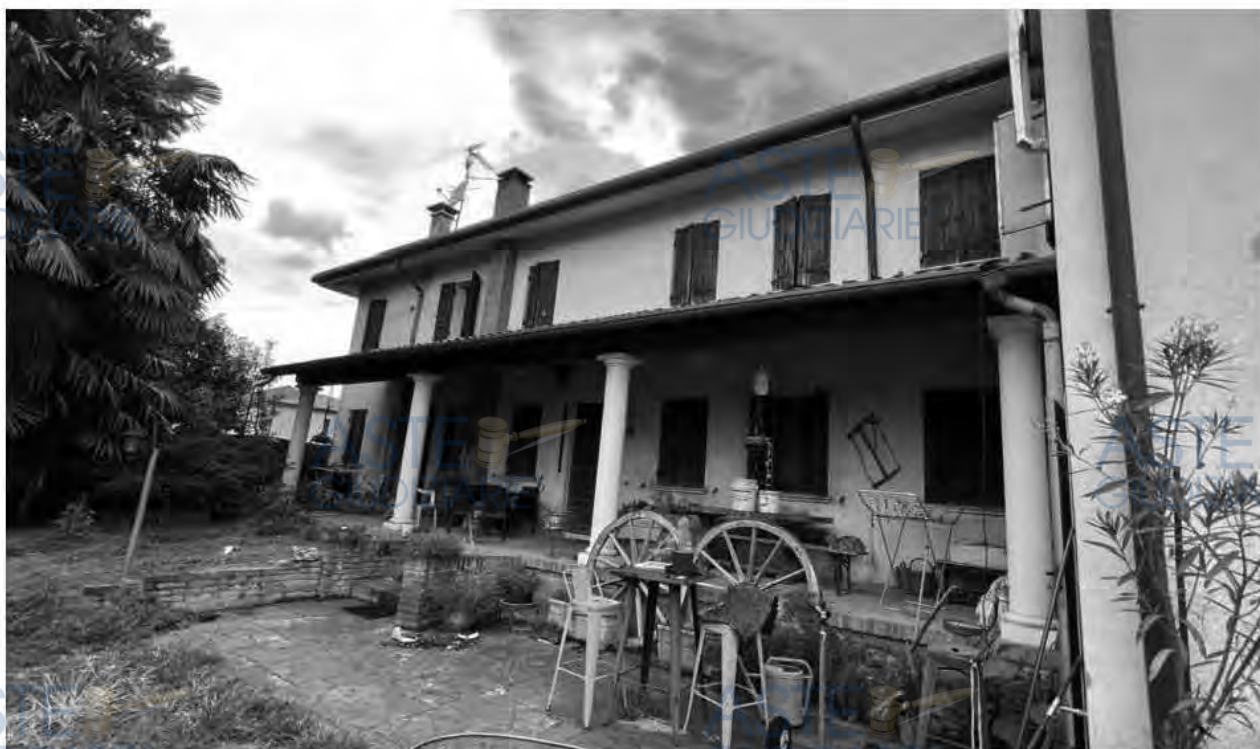
FOTO 8 - Fronte sud 3.d
