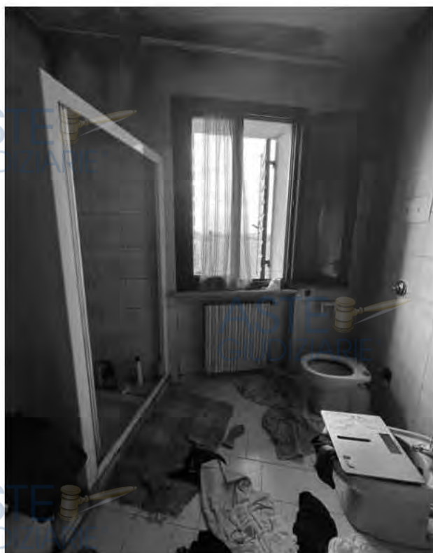
FOTO 12 - Bagno piano primo 2.d
