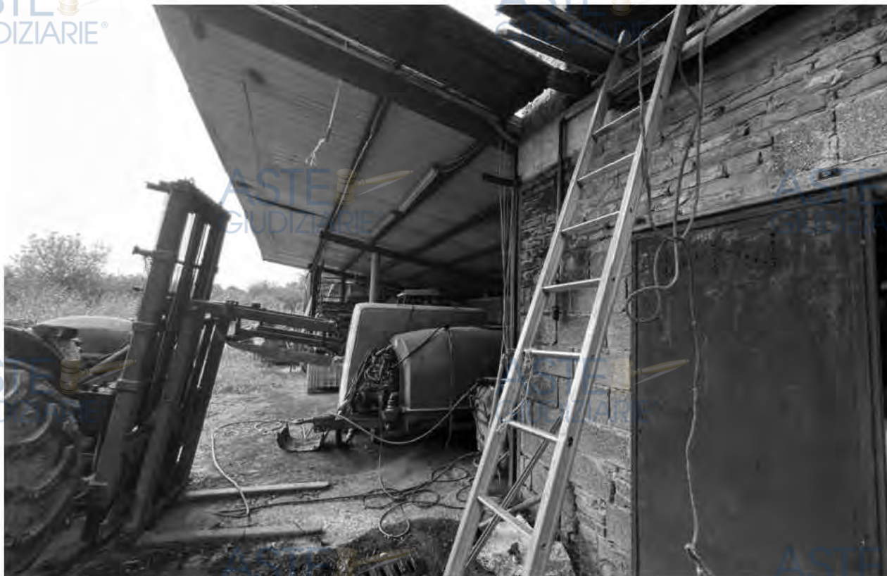
FOTO 17 - Tettoia piano terra 2.b
