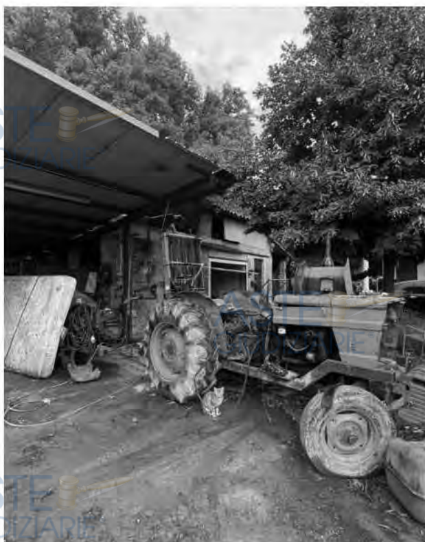
FOTO 18 - Tettoia piano terra 2.b
