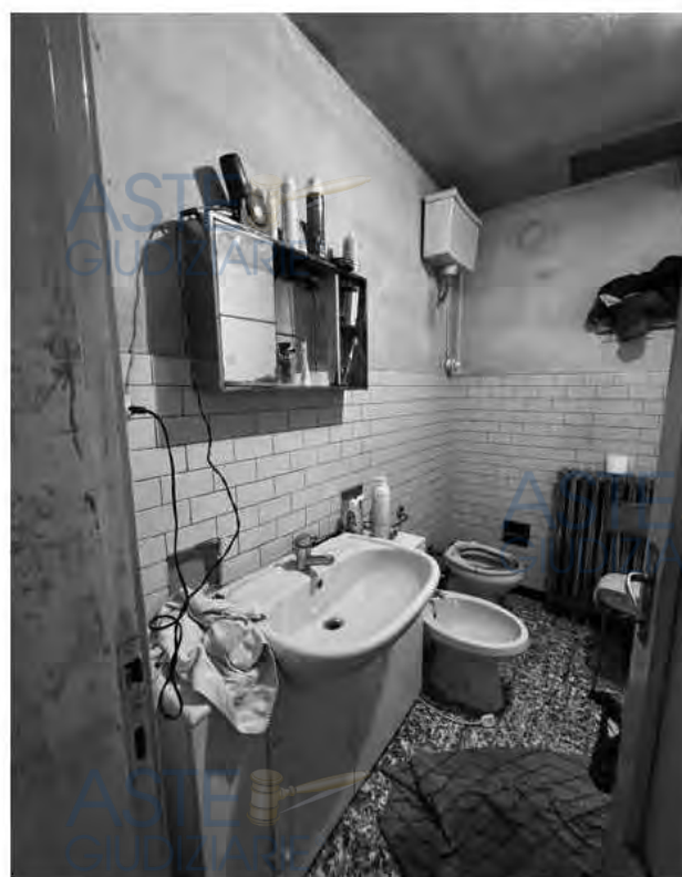
FOTO 22 - Bagno piano primo 2.d
