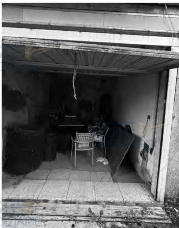
FOTO 15 - Autorimessa piano terra 2.b
