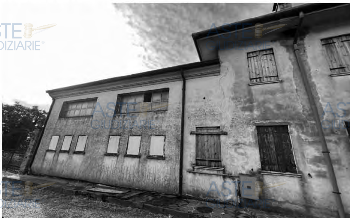
FOTO 2 - Fronte nord 3.c
