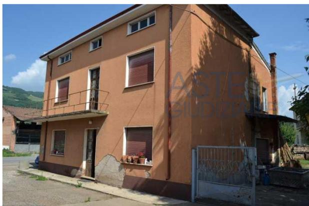
foto 4 - il blocco edificato di primo impianto dell'abitazione abbandonata è un parallelepipedo sormontato da una copertura a quattro falde. Quanto alle sue condizioni strutturali, basti dire che un'esauritiva campagna di prove dirette alla caratterizzazione meccanica degli elementi portanti (muri, solai, travate lignee) avrebbe costi paragonabili al valore residuo del manufatto
