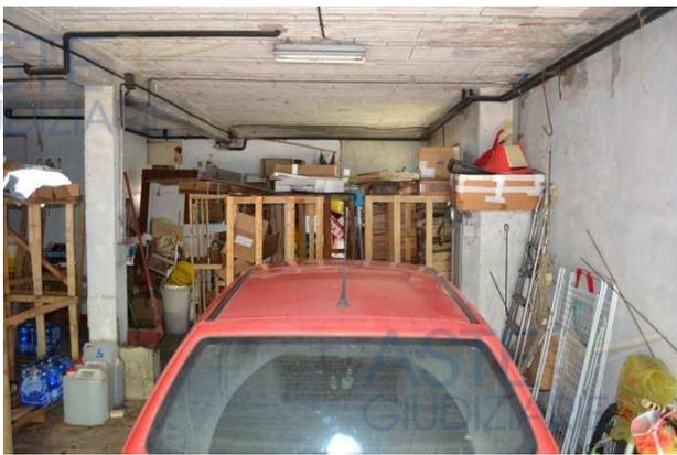
foto **3** - a sinistra, di lato e in alto, si vede bene che centralmente – a partire dalle fondazioni – la struttura si regge su un solo pilastro (misure apx 25x25cm) sormontato da una trave fuori spessore di solaio e non, quindi, dallo spallone visibile in catasto né dai setti multipli di cui al primo stato approvato
