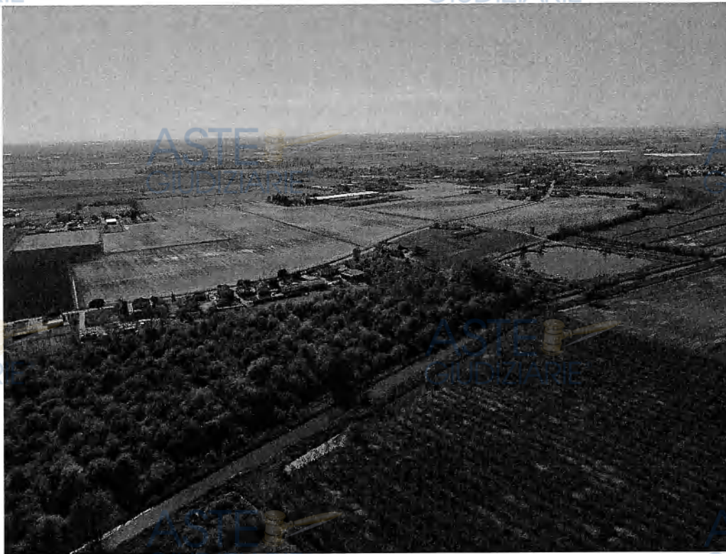
Vista aerea Lotto 1
