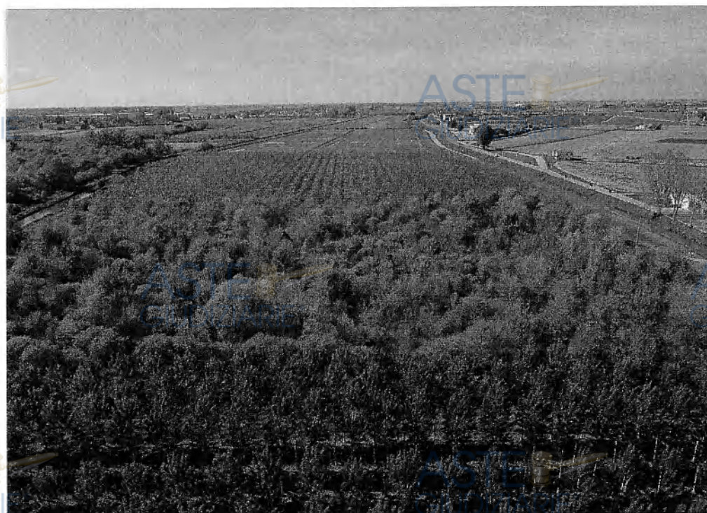
Vista aerea Lotto 2
