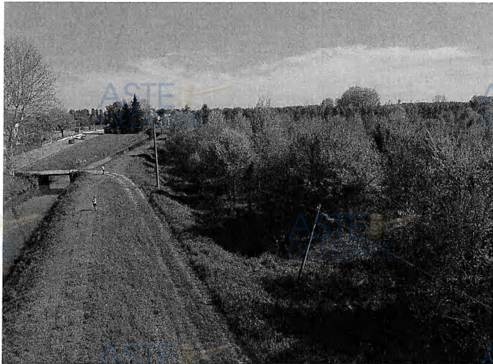
Vista aerea Lotto 2 – lato Nord Ovest
