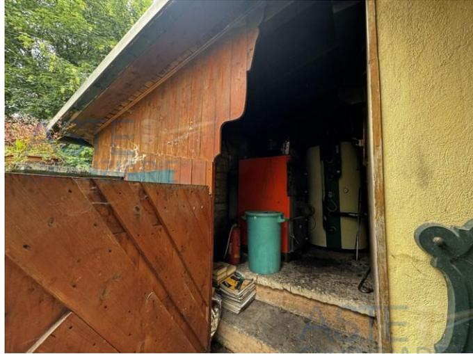
A Nord del lotto è presente un locale chiuso che catastalmente però risulta una tettoia. Tale locale è utilizzato per gli impianti dell'abitazione, infatti, contiene la caldaia a legna, un boiler d'accumulo e altri impianti. Il suo volume non trova corrispondenza in nessun progetto depositato. Pertanto, andrà smantellato e gli impianti dovranno eventualmente essere spostati in un altro locale dell'abitazione o degli accessori.
