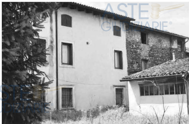
foto 5 - vista da nord est del prospetto nord sul retro dell'abitazione (centro foto) in località Le Ché, con la parete esterna sottogronda del piano secondo – zona notte con tetto in falda – con vistosa igrofanìa per percolazione all'imposta della falda per l'inadeguato presidio della grondaia e copertura
