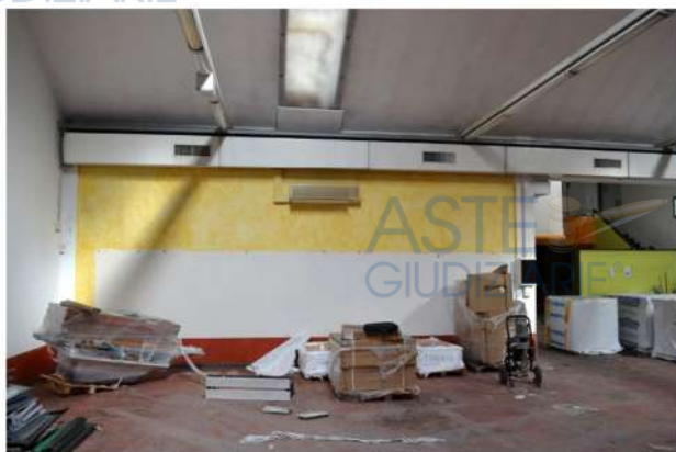
foto 4 - gli split nelle palestre sono alimentati da calate tracciate attraverso le condutture di distribuzione principali, quelle correnti sotto le reni delle volte a botte di copertura. Non è chiaro se le macchine interne prendano potenza da apparecchi sui tetti, come sembrerebbe dalle aereofoto
