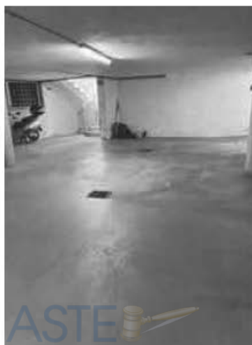
18 Corsia di manovra sub 36
