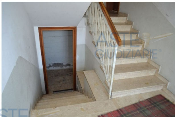
foto 4 - il vano scala comune sub 10, al pianterreno, copre per metà la quota di sbarco al seminterrato e per l'altra metà quella del rialzato. Le gradinate sono su solette rampanti. I rivestimenti sono in lastroni marmorei smaltati; le finiture sono a tinte bianche e beige
