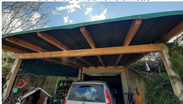
Foto tettoia antistante Autorimessa
