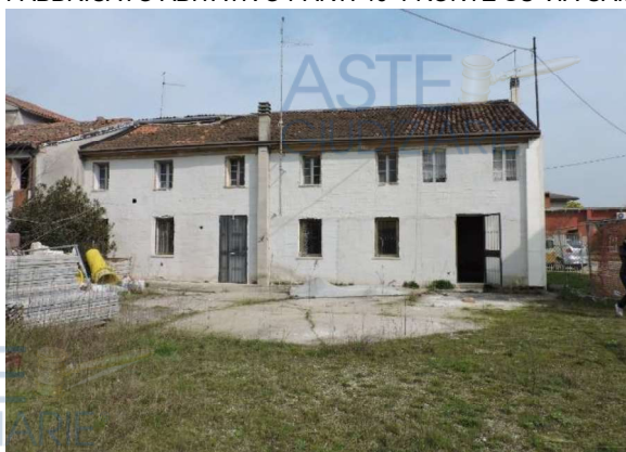
FABBRICATO ABITATIVO PART. 40 FRONTE INTERNO AL LOTTO
