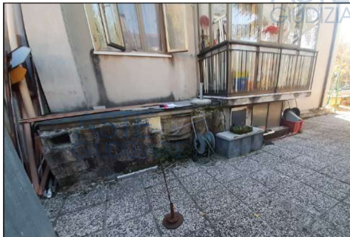
Basso manufatto abusivo a ridosso del fabbricato
