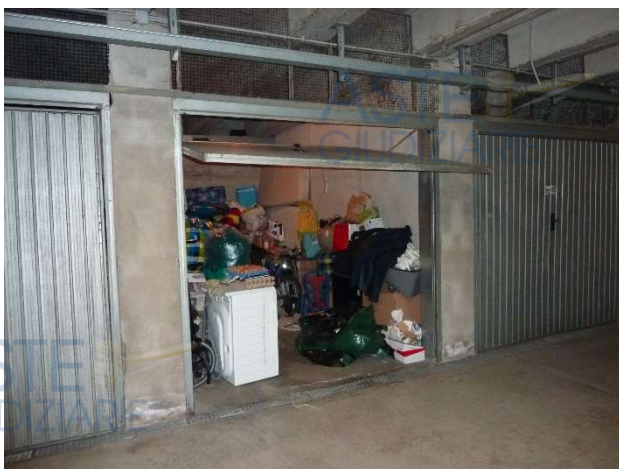
Corsia di manovra piano interrato
