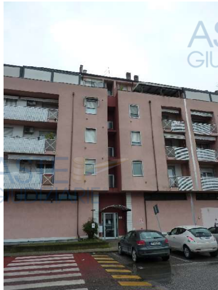
Dettaglio ingresso del fabbricato
