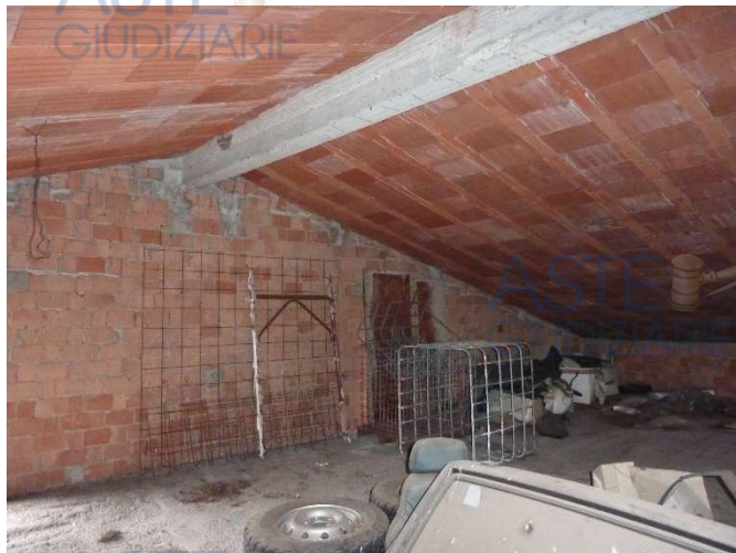
Vista interna deposito sub 3 piano primo
