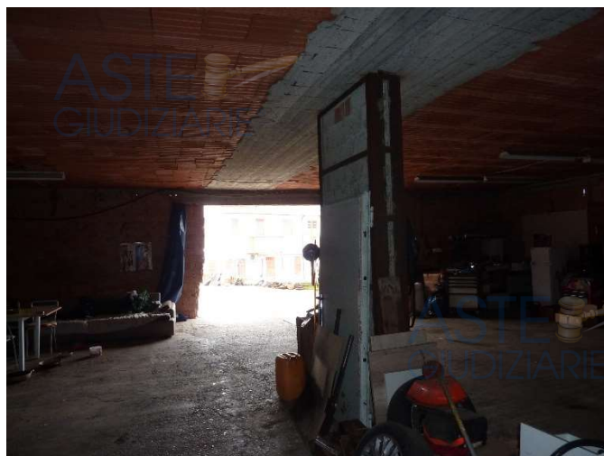
Vista interna deposito sub 2 piano terra
