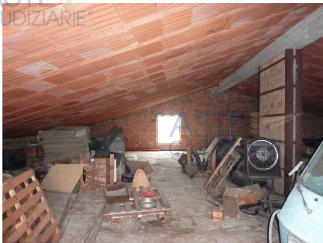
Vista interna deposito sub 3 piano primo
