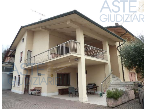
Dettaglio fronte principale del fabbricato
