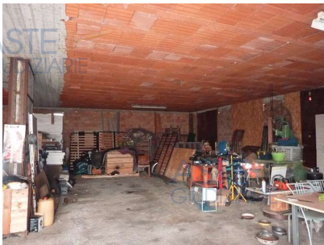
Vista interna deposito sub 2 piano terra
