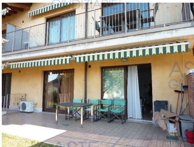
Vista fabbricato dalla corte pertinenziale
