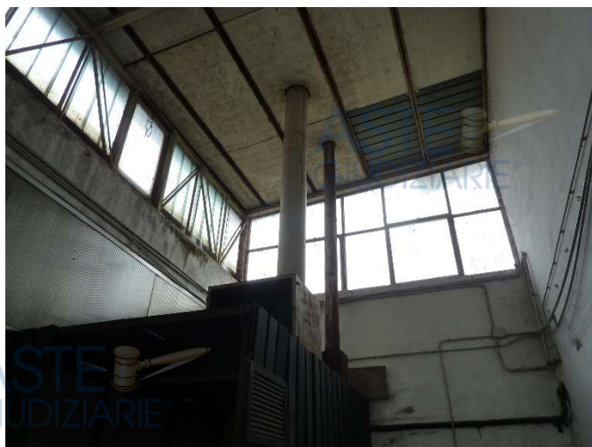
Locale deposito piano interrato sub 8
