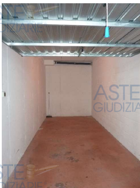
Autorimessa sub 38 piano interrato
