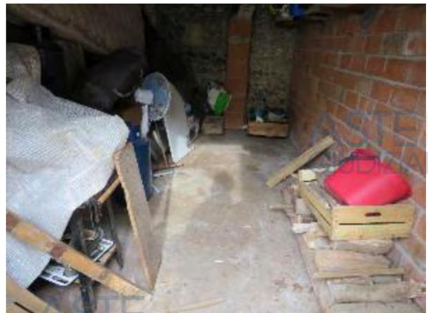
L'autorimessa risulta senza finiture, assenza di intonacatura e tinteggiatura, pavimentazione in battuto di cemento, portone d'ingresso in metallo.
