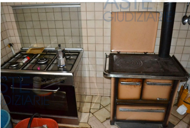
foto 2 - anche la stufa economica installata nel cucinino contribuisce alla climatizzazione del piano terra, in particolare dell'ala servizi interclusa tra il fabbricato principale e il confine di proprietà nord. Lo scarico dei fumi di combustione passa attraverso nicchie d'alloggiamento di molto dubbia caratteristica di coibentazione e di reazione al fuoco
