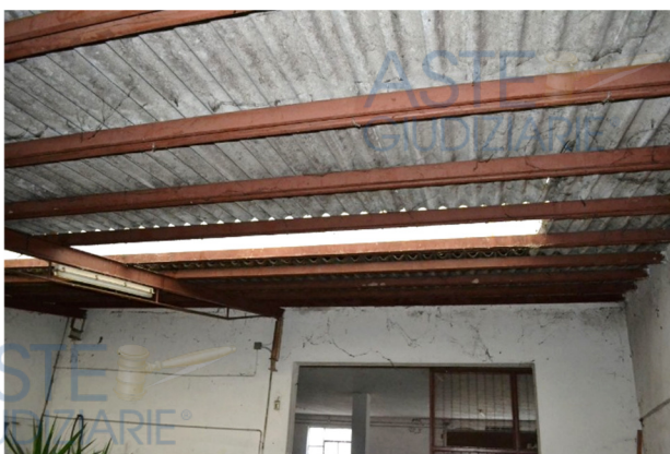
foto 5 - il tetto del magazzino n. 4, a differenza di praticamente tutto il resto dei corpi di fabbrica coperti della seconda unità negoziale, è realizzato in lamiera grecata anziché in amianto. Un lucernario aperto su quasi tutta la larghezza della falda contribuisce all'illuminazione del vano; idem dicasi per l'attigua cantina grande. H_{max} = 4,45\text{ m} – H_{min} = 2,97\text{ m}
