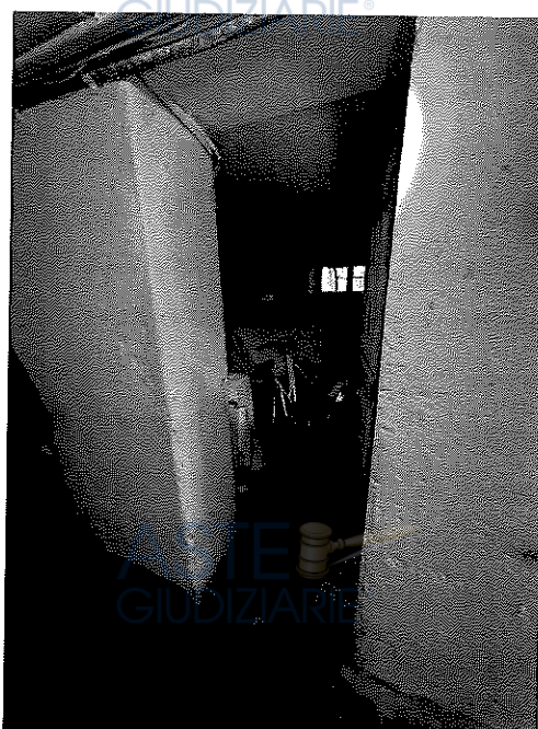
ACCESSO ALLA CANTINA SUB. 24
