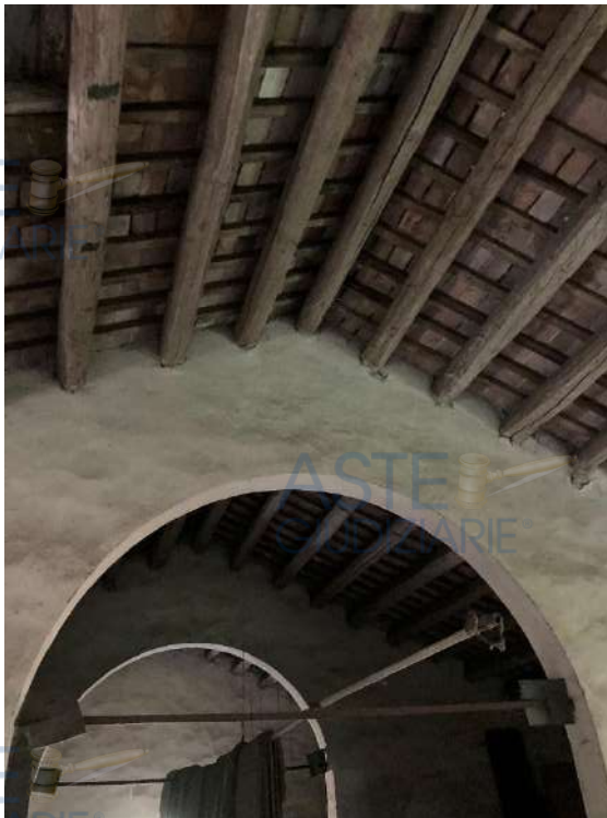
COPERTURA PIANO SECONDO – SUB.18
