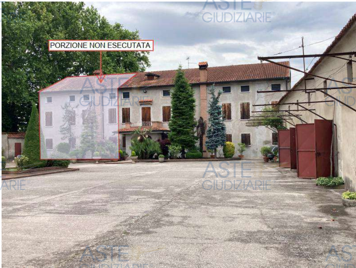
VISTA SULL'IMMOBILE DEL MAPPALE 425 CON EVIDENZIAMENTO DELLA PORZIONE NON ESECUTATA
