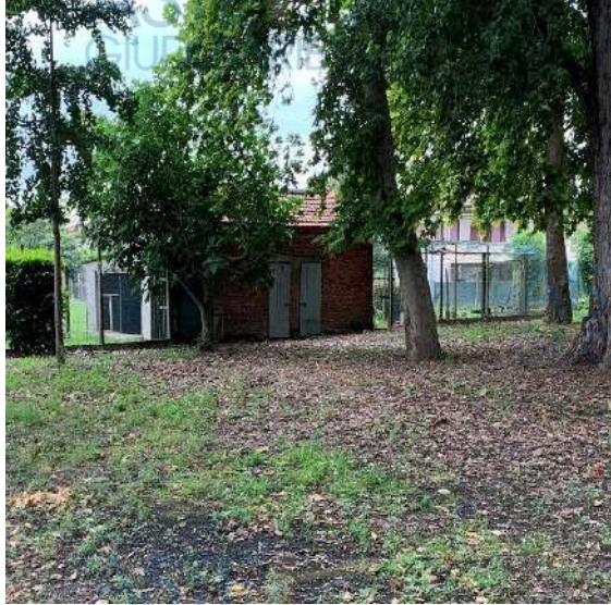
SECONDO DEPOSITO PERTINENTE ALL'ABITAZIONE SUB.3 ESTERNO - ZONA PARCO ALBERATO
