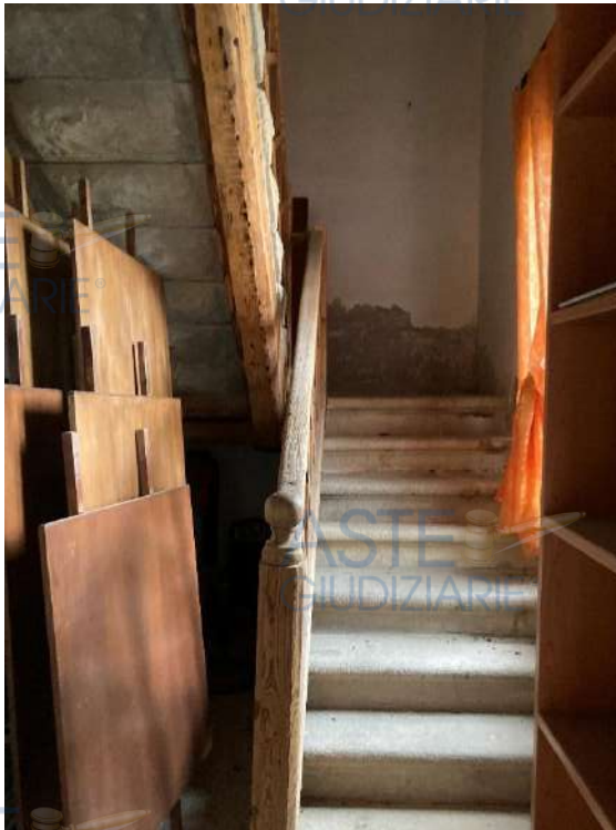
SCALE DI COLLEGAMENTO AL PRIMO PIANO (SUB.18)
