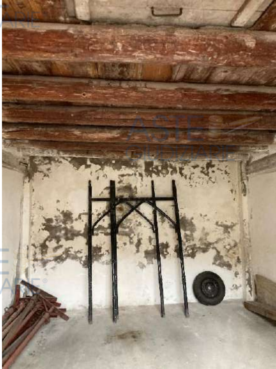
BOX AUTO PIANO TERRA - DEPOSITO
