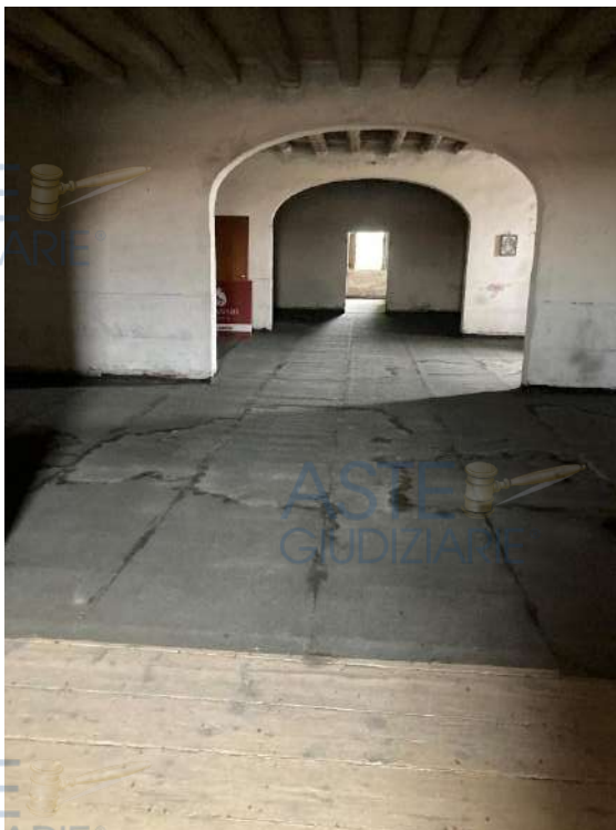
LOCALE DEPOSITO PIANO PRIMO – SUB.18
