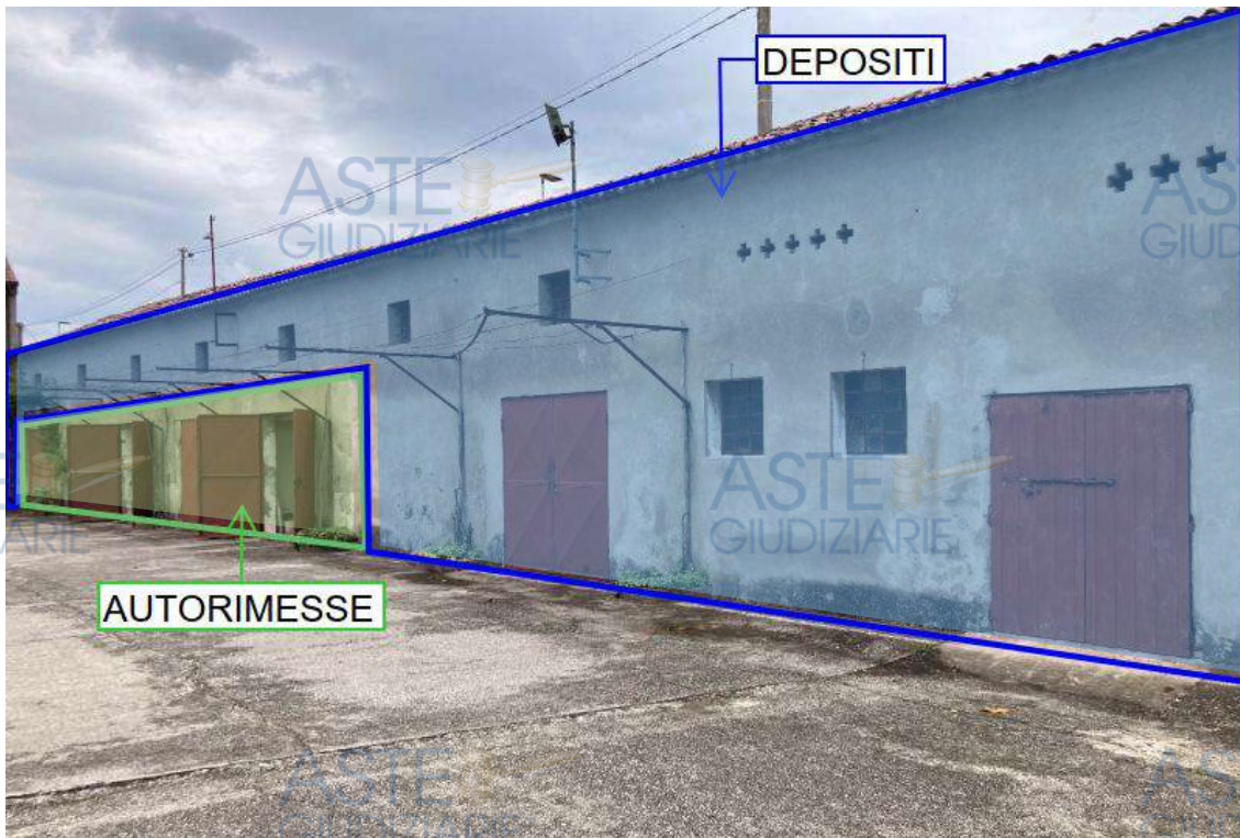
VISTA ESTERNA SUI SUB. 9,10,11,12,13,15,16 e 20 DEL MAPPALE 1044
