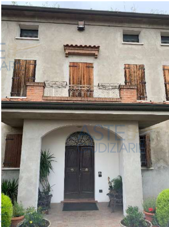
INGRESSO ALL'ABITAZIONE DALLA CORTE COMUNE
