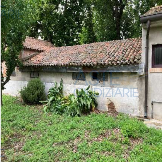
DEPOSITI PERTINENTI ALL'ABITAZIONE SUB.2 - VISTA DAL MAPPALE 1028
