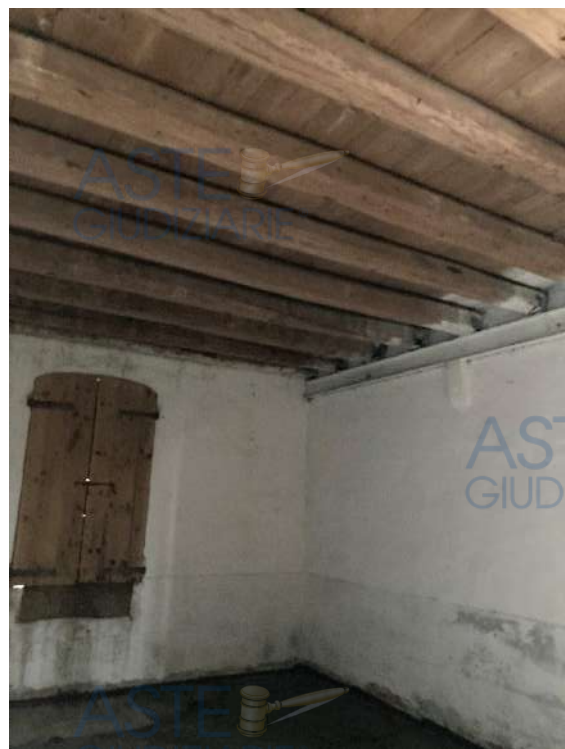
LOCALE DEPOSITO PIANO PRIMO – SUB.18
