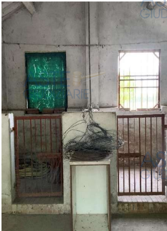
LEGNAIA SUB.2 – NON RISTRUTTURATA
