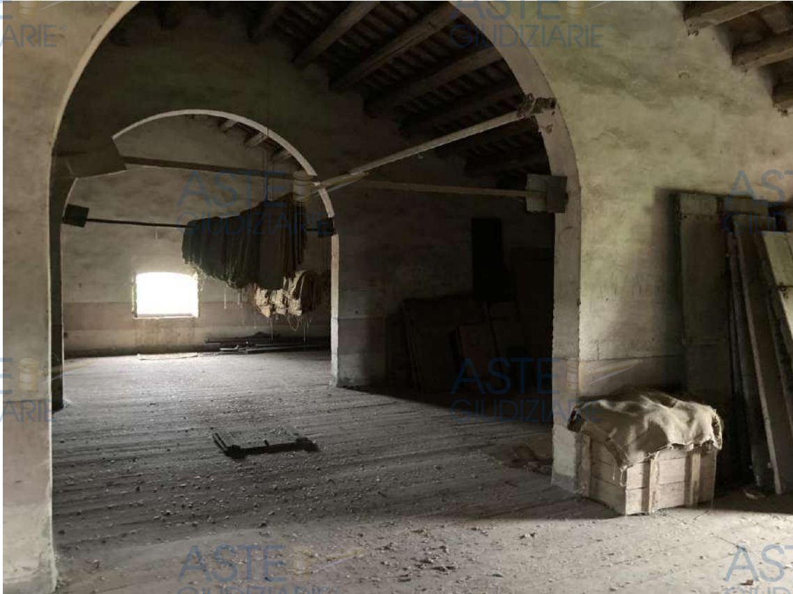
LOCALE DEPOSITO PIANO SECONDO
