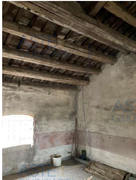
LOCALE DEPOSITO PIANO SECONDO – SUB.18
