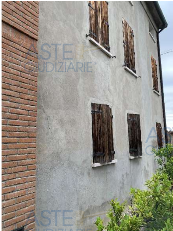
VISTA ESTERNO DELL'ABITAZIONE LATO CORTILE P1-2
