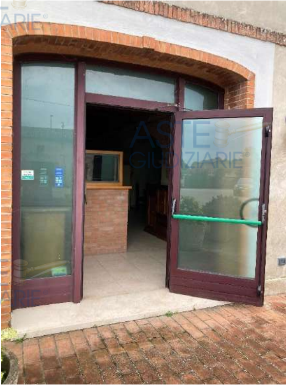
INGRESSO AL SUB. 18
