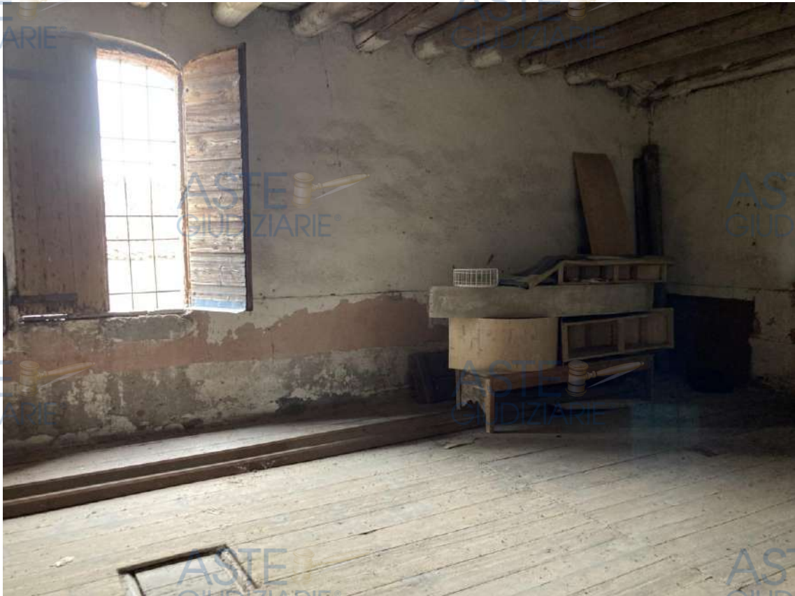
LOCALE DEPOSITO PIANO PRIMO – SOLAIO IN LEGNO
