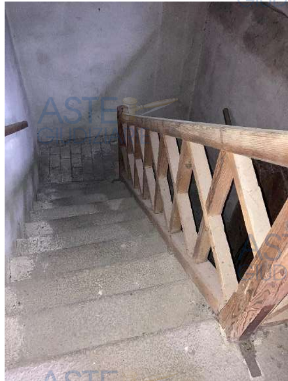
SCALE DI COLLEGAMENTO AL PRIMO PIANO (SUB.18)
