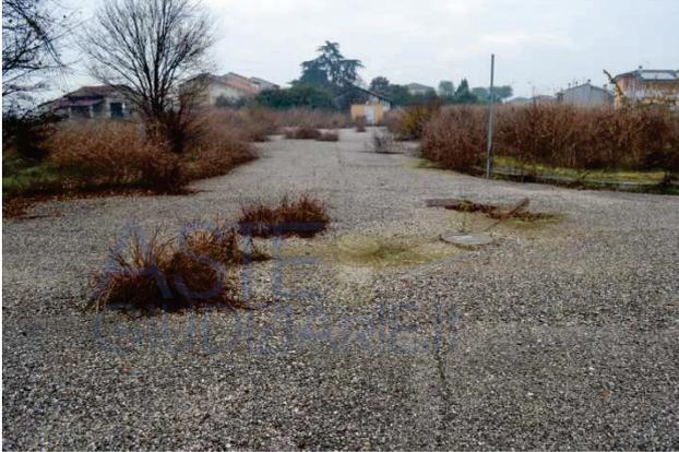
foto 2 - vista dall'incrocio centrale (in primo piano) della viabilità interna del PUA ORTI 3 del tratto est della strada per l'accesso ai lotti larga m 7,00, con marciapiedi di m 1,50 e parcheggi di m 2,50 e con binder in pessime condizioni - senza manto d'usura. Sullo sfondo al centro si vede la cabina elettrica installata sul m.n. 275
