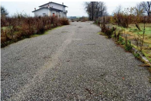
foto 1 - vista da sud in via Don R. Tressino della strada d'accesso del PUA ORTI 3 costituente opera di urbanizzazione primaria convenzionata larga m 7,00, con marciapiedi di m 1,50 e con binder in pessime condizioni – senza manto d'usura. In alto a destra si vede l'edificio di terzi realizzato al rustico sul lotto n. 3 (non staggito)
