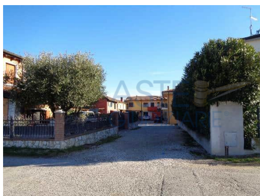
Accesso alla corte comune su Via Perarolo
