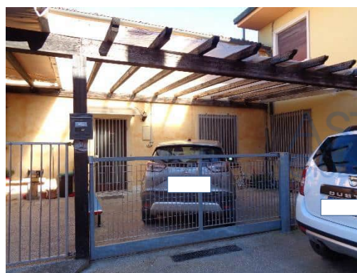
Accesso all'abitazione, al civico 62 D
