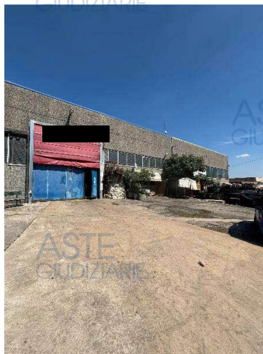
PIAZZALE – AREA DEPOSITO
