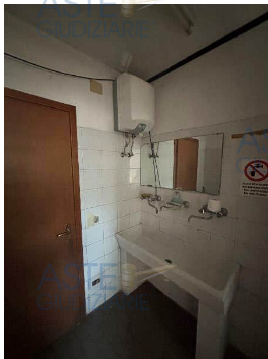
ANTIBAGNO WC CAPANNONE
