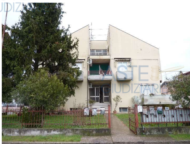
Viste fronte del fabbricato.
