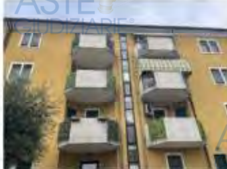
2 prospetto sud edificio principale
