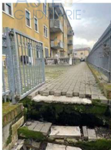
4 Prospetto nord edificio retro
