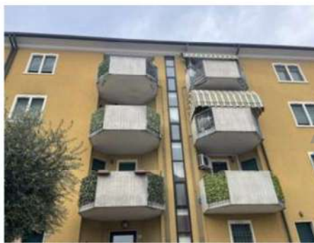
2 prospetto sud edificio principale
