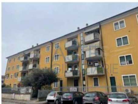
1 Prospetto sud principale
