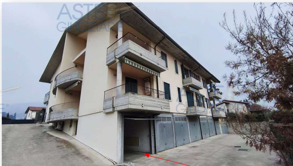
Prospetto sud/ovest -garage
