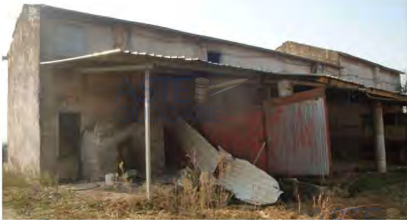
Tettoia sul retro del mapp. 871 sub. 1
