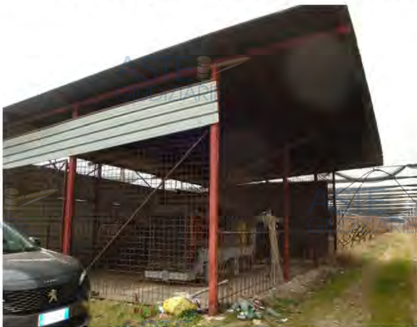
Tettoia insistente sul mapp. 910
