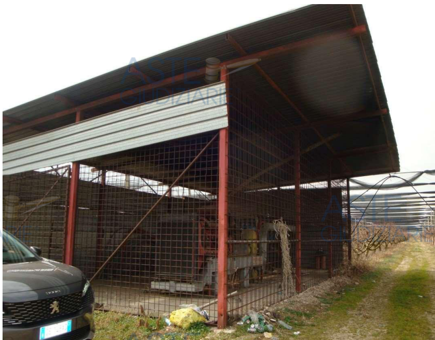
Tettoia insistente sul mapp. 910
