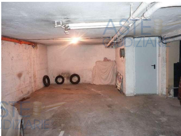
Vista interna autorimessa sub 10
