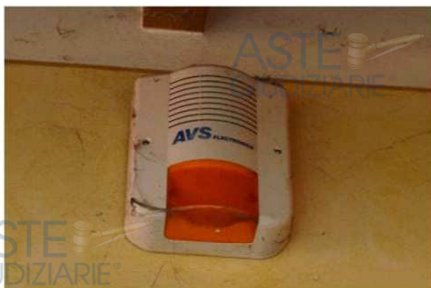
foto 1 - gruppo esterno dell'impianto d'allarme, con sirena da 105 dB a tre metri, sistema antimanomissione e lampeggiante. Dotata di led di segnalazione dello stato di funzionamento. Carcassa in ABS resistente agli agenti atmosferici. Dispositivi antintrusione interni costituiti da sensori volumetrici. Non si ha notizia dell'eventuale manutenzione periodica dell'apparato
