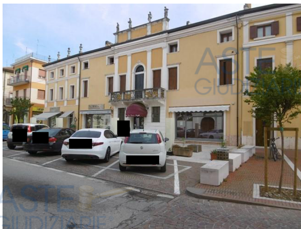
FOTOGRAFIE ESTERNE DEL FABBRICATO – sub 43 e 44 -
