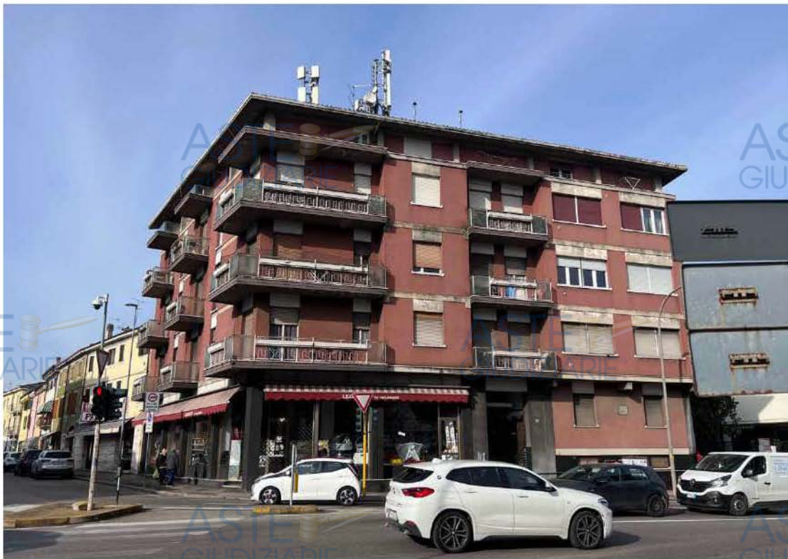
FOTO 1 - Fronte Est/sud, via Albere incrocio via Mantovana
