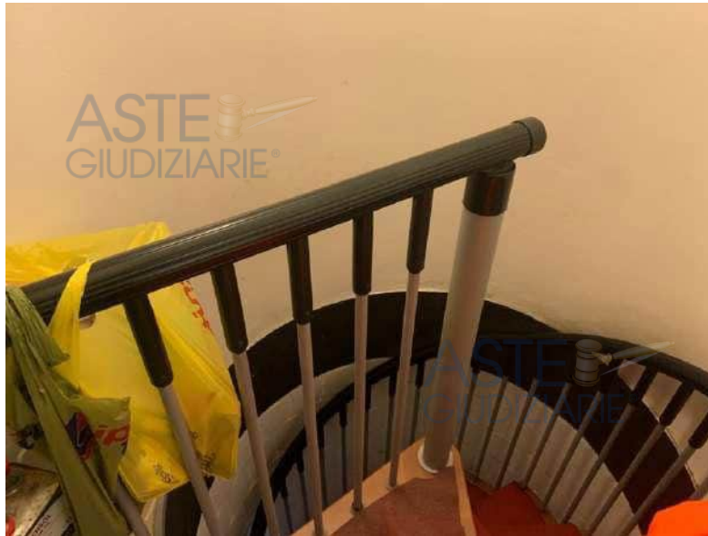
Scala a chiocciola di collegamento tra appartamento e scantinato
