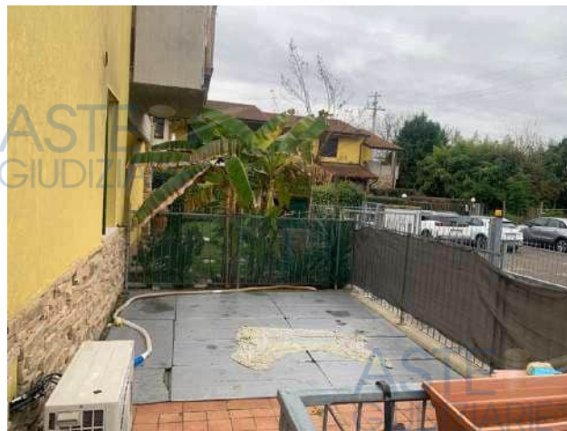
Balcone camera – lato nord
