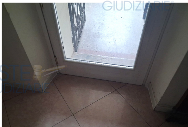
foto 1 - contorno in spessore di muratura lungo le aperture finestrate. La svasatura-tipo è obliqua dietro l'infisso e rettilinea davanti, non obliqua a tutto spessore. Si noti poi che la soglia d'ingresso tra il vestibolo e il corridoio centrale ha un'alzata con tanto di davanzale marmoreo. La protezione dell'accesso è rafforzata da un'inferriata apribile in ferro battuto
