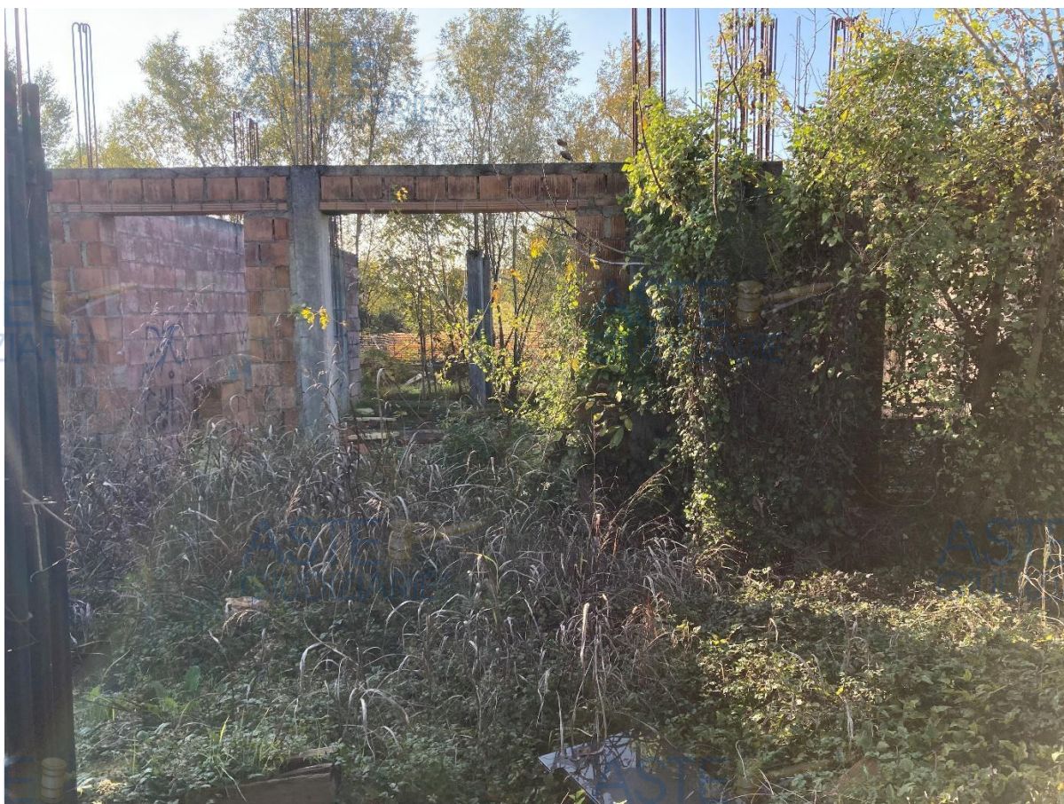
Figura 1 - Questo quanto è possibile vedere dalla Via di lottizzazione Gianfranco Miglio
