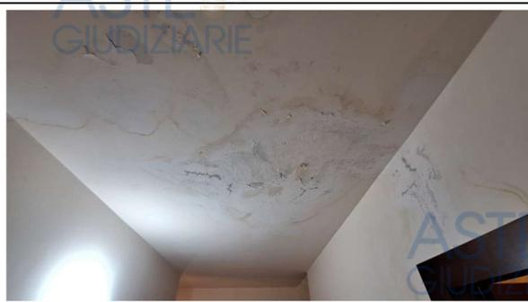
Figura 16: traccia infiltrativa rilevata sul soffitto del piano secondo
