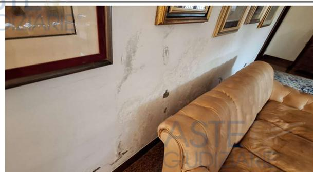
Figura 15: traccia infiltrativa rilevata nel soggiorno
