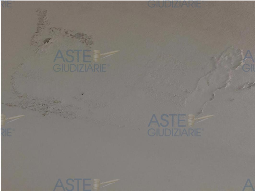
SCROSTAMENTO DELL'INTONACO SU SOFFITTO AL PRIMO PIANO
