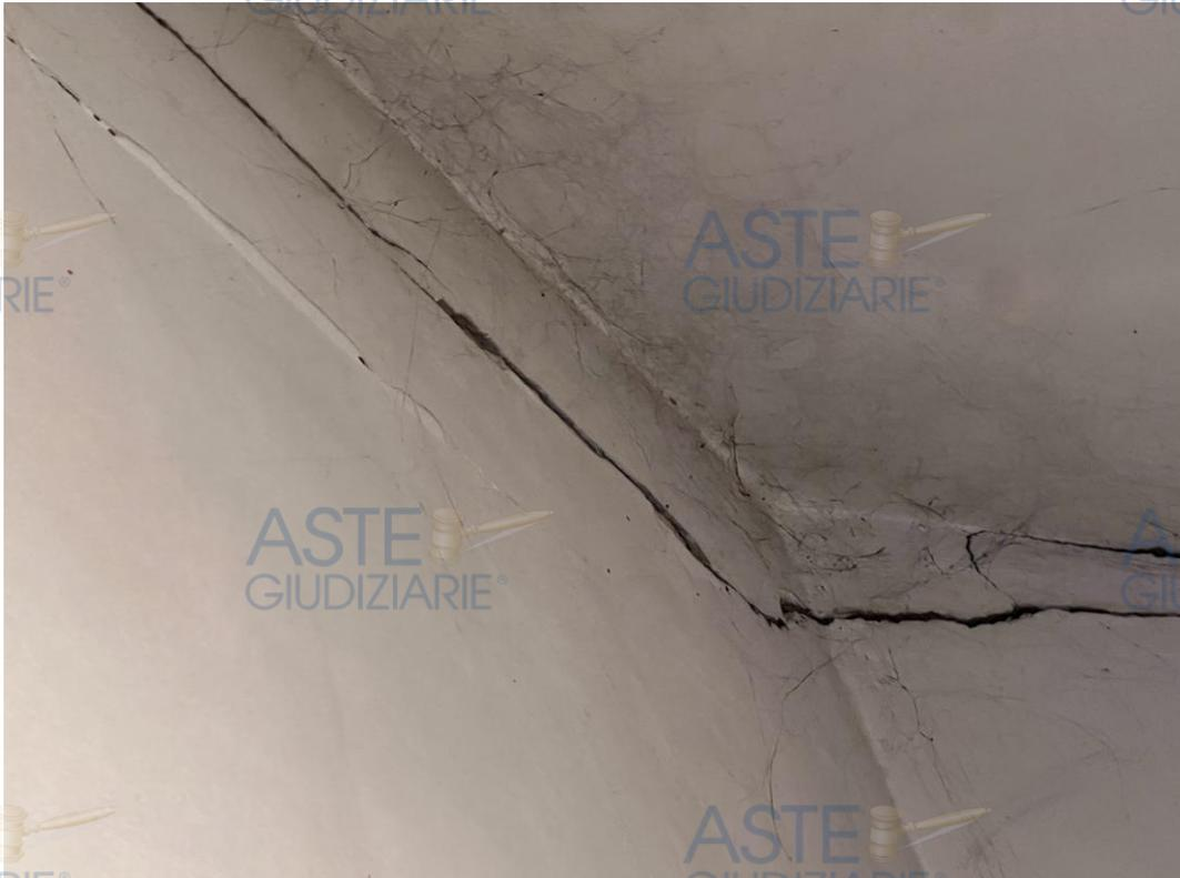
CREPA STRUTTURALE SUL MURO DI SEPARAZIONE CON ALTRA UNITA'
