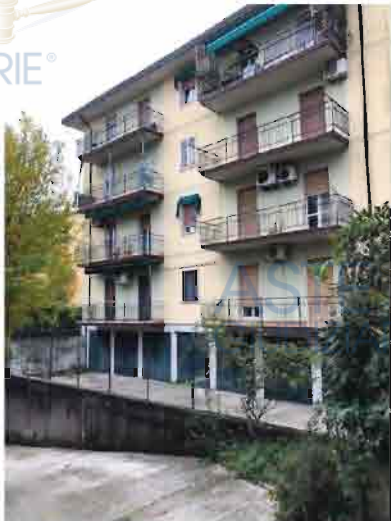
Retro edificio con autorimesse
