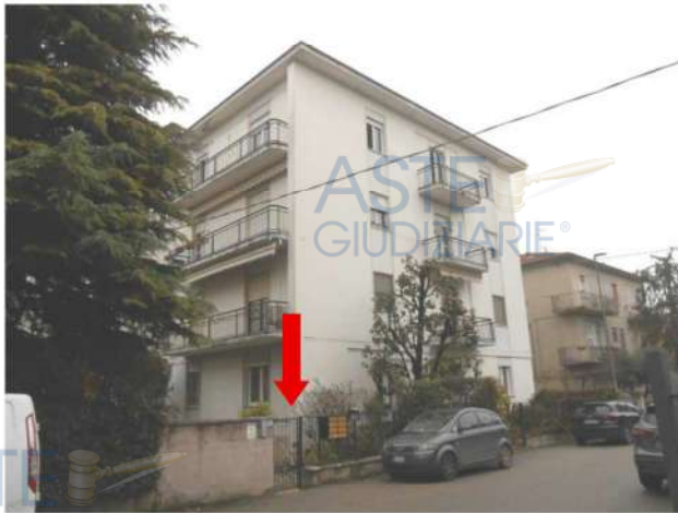
Ingresso pedonale da Via Grigolin
