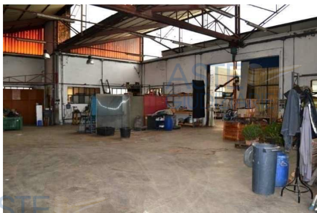
foto 3 - scorcio interno dell'angolo sud ovest dell'officina m.n. 96 CEU realizzata in varie riprese nel 1986/1999 con copertura a shed tripartita (al centro nella foto la falda ovest) integrata nel 1995 con l'edificio per uffici/mostra/w.c. e successivamente con l'aggiunta di una campata a shed dell'officina (collegamento a destra foto)
