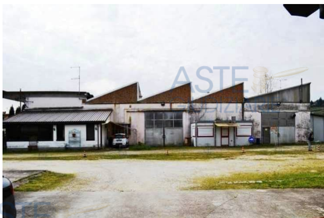
foto 1 - Prospetto nord dell'officina m.n. 96 CEU con la parte est realizzata in varie riprese nel 1986/99 con copertura a shed tripartita (centro foto) integrata nel 1995 con l'edificio per uffici, mostra e w.c. (sinistra foto, davanti all'officina di terzi) e nel 2002 con aggiunta di una campata a shed dell'officina (destra foto), il tutto con l'accesso comune da via Perazzolo a est. Il prefabbricato centrale ha funzioni sostitutive dell'ex ufficio
