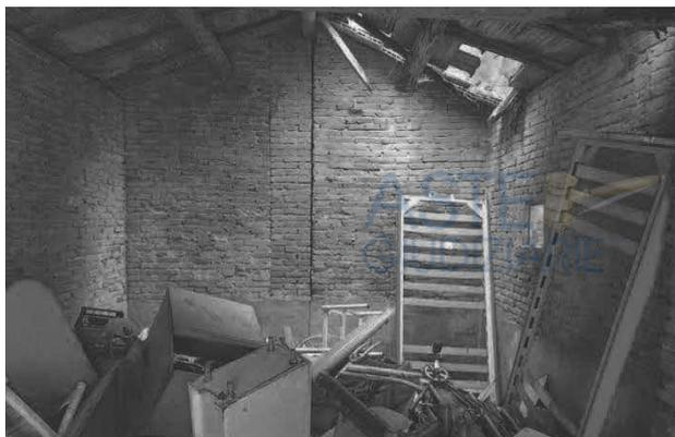
foto 3 - il paramento murario dell'accessorio, verso il muro cieco sul retro, presenta due interruzioni di continuità in corrispondenza di altrettante riprese di giunto, ma gli ortostati si presentano complanari. Oltre che dissestato in copertura, il manufatto si presenta ingombro di masserie
